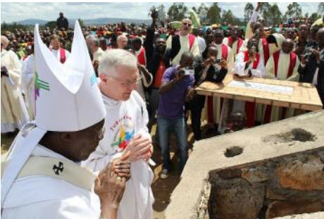
Erzbischof Simon Ntamwana und Domkapitular Josef Blomenhofer bei der feierlichen Grundsteinlegung in Bugendana
